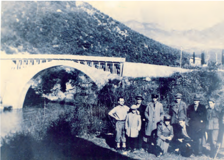
Il ponte di Perati, prima della distruzione e quel che ne resta oggi.
